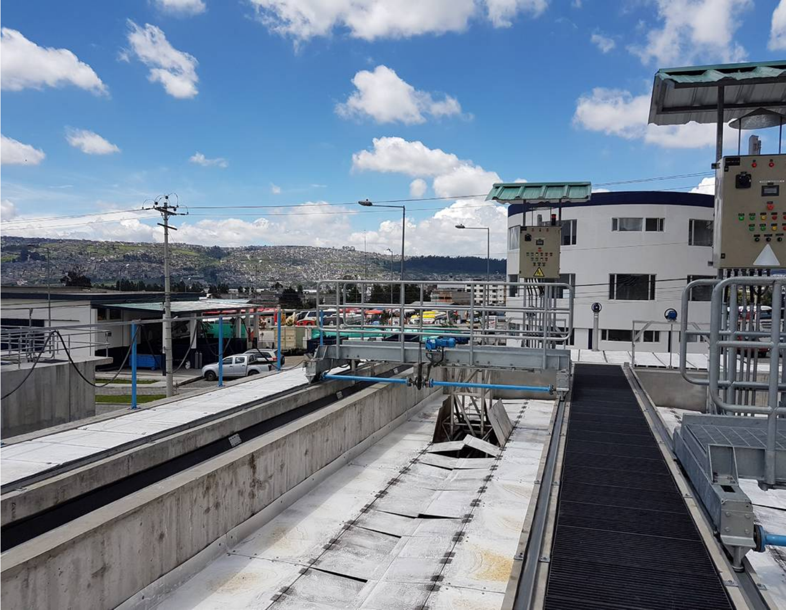
• PUENTE BARREDOR LONGITUDINAL
