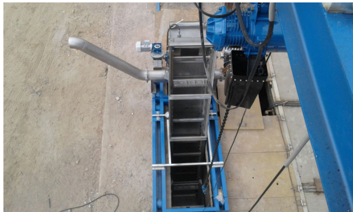
Vista superior luego de montaje de reja automática de desbaste para proyecto “Planta elevadora Coquimbo”.
