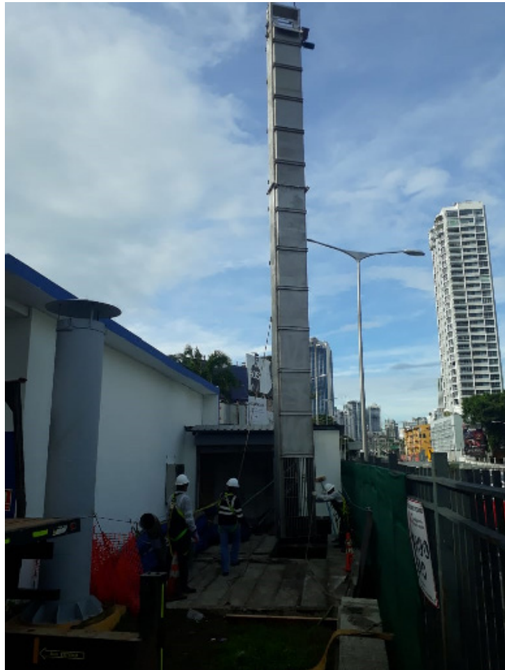
Fabricación y montaje para proyecto “Pozo via Brasil”, Panamá. Reja diseñada con 17 [m] de largo.
