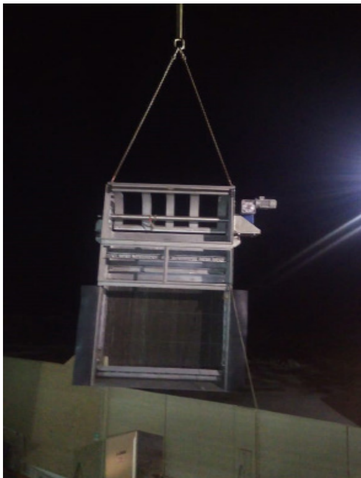
Fabricación y montaje para proyecto “Emisario Coquimbo”. Reja diseñada con 2000 [mm] de ancho.
