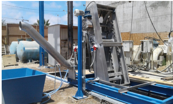
Puesta en marcha reja automática de desbaste para proyecto “Planta elevadora Coquimbo”. Cliente: Aguas del Valle.
